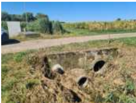
Présence de fossés busés -> pose en sur-profondeur
