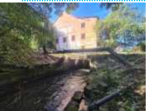
Franchissement aérien de la Moder -> passage en forage dirigé
