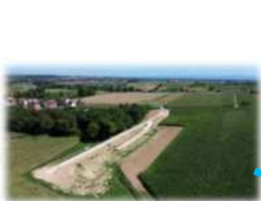
Ouvrages de rétention amont
