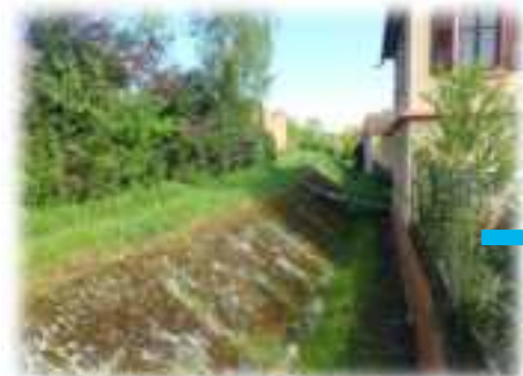
Gestion des digues
