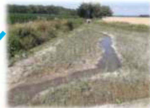
Renaturation de cours d'eau
