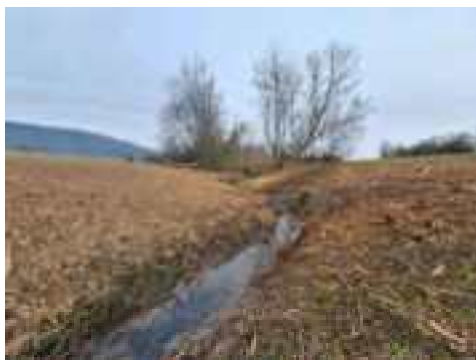
Traitement de la végétation au droit du futur ouvrage
